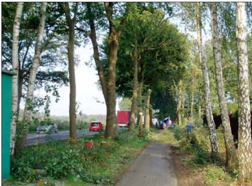
Baustelle an der Siedlung Rükel
